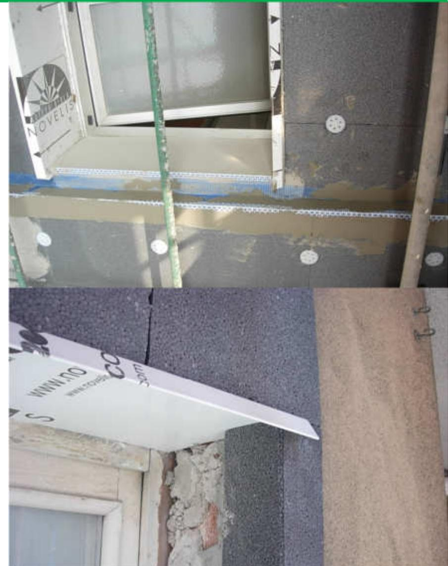
Isolamento in Lastre in polistirene addittivato con carbografite spess. 10 cm
